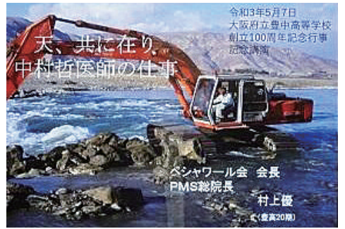
ブルドーザーを運転する中村医師
