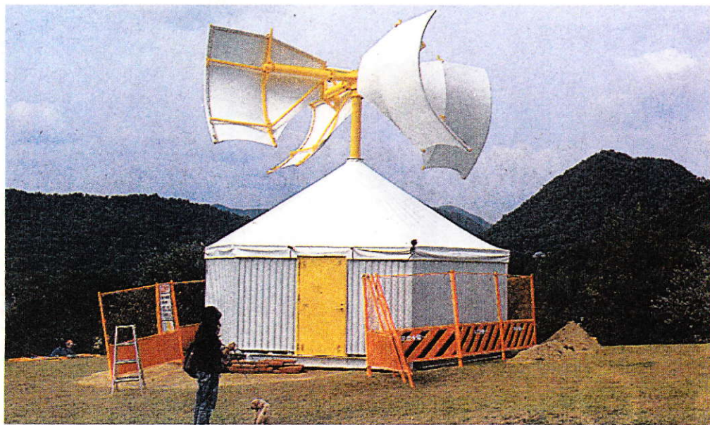
設置作業が進む「里山風車」＝三田市尼寺の県立有馬富士公園
